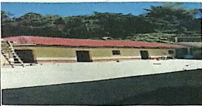
Foto 1: PROYECTO FINALIZADO. Sustitución de lamina troquelada aluzinc calibre 26 en módulo de cocina, sala de docente y dirección.
